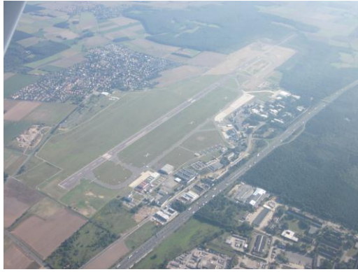
Der Forschungsflughafen Braunschweig – Pistenverlängerung im Bau
